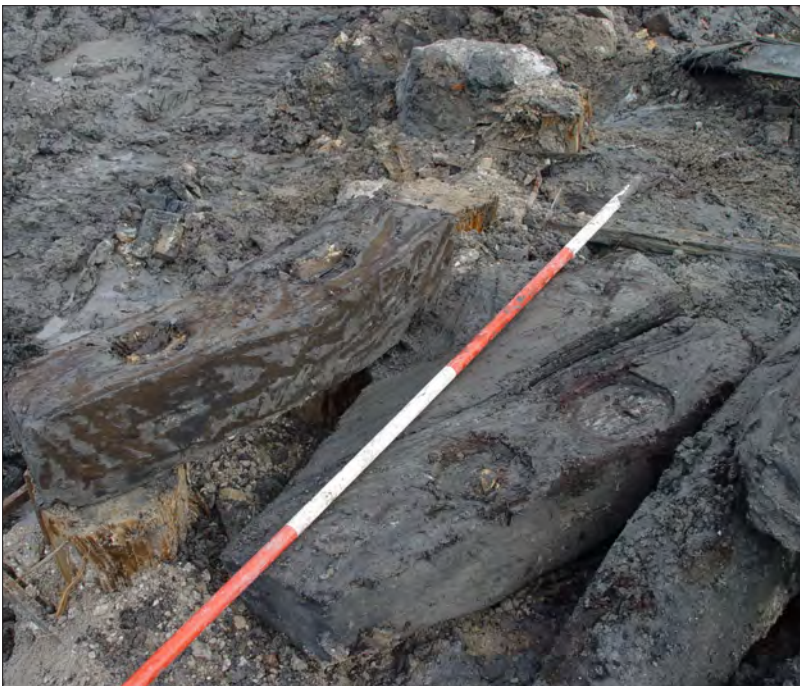
Afb. 45. Boven: onderzijde van een kruishout onder de noordoosthoek van de fundering van Muur 1. Onder: kessen uit de fundering van Muur 1.
