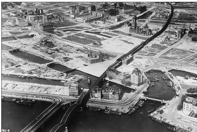
Afb. 3. De omgeving van de Oudehaven en de Wijnhaven voor en na het bombardement van 1940, gezien vanuit het zuidoosten. Het onderzochte gebiedje 'Wijnhaeve' bevindt zich onder het spoorviaduct, bij de kruising met de Wijnhaven.
